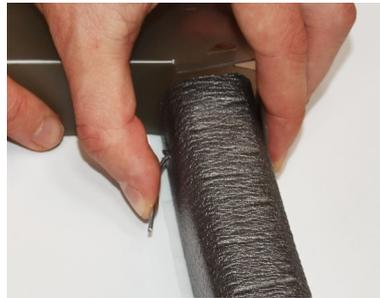
Traversez la mousse sur toute son épaisseur. Verrouillez en pliant l'épingle sous la mousse. Renouvelez l'opération sur le deuxième morceau de mousse.
