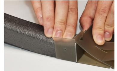
Collez ces 3 cm sur le tube en butée avec le côté du tube. Répétez l'opération sur l'autre côté du tube avec le deuxième morceau de mousse. *Attention ne laissez pas d'espace entre la mousse et le coin supérieur du tube.*
